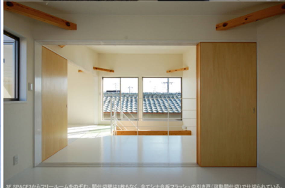
3F SPACE3からフリールームをのぞむ。間仕切壁は1枚もなく、全てシナ合板フラッシュの引き戸(可動間仕切)で仕切られている。
