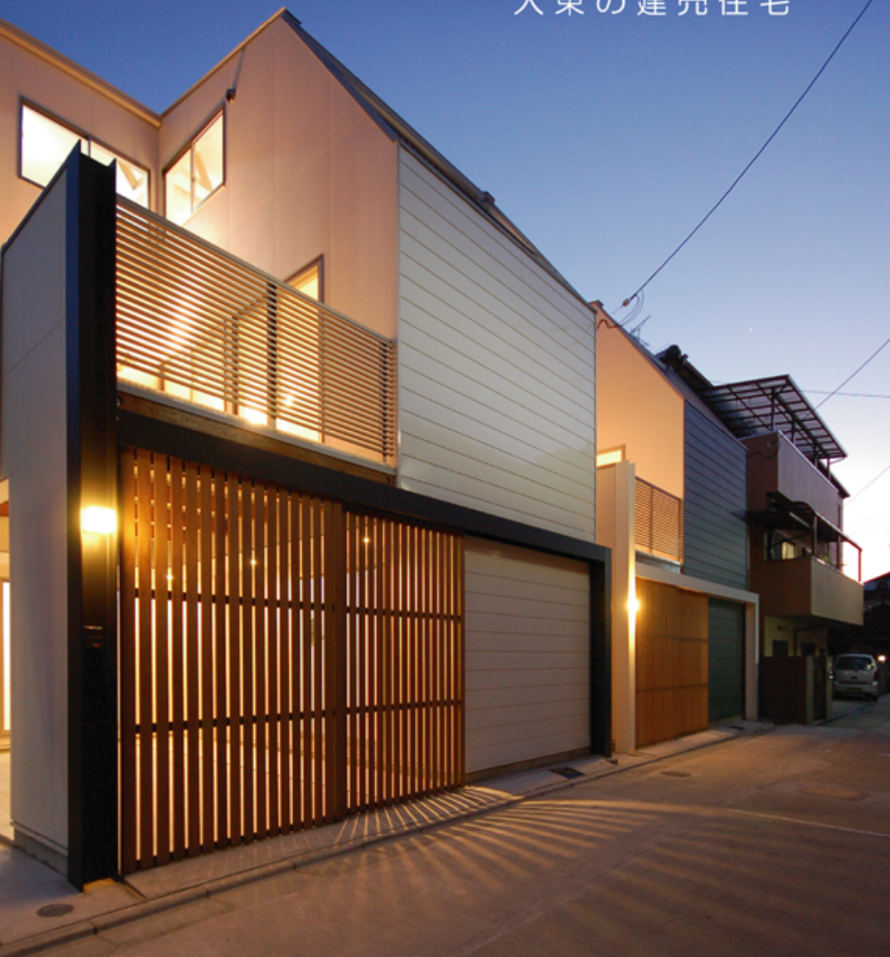
北東からの夜景。ガルバリウム鋼板貼の外壁と木製ルーバードアによるファサード。プライバシー確保のため、道路面には一切窓を設けていない。
